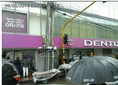
Fotografía No. 2. Elemento de PEV tipo AVISO EN FACHADA por Calle 20 sin registro ante la Secretaría Distrital de Ambiente y elementos tipo PENDÓN con afectación visual al espacio público.
